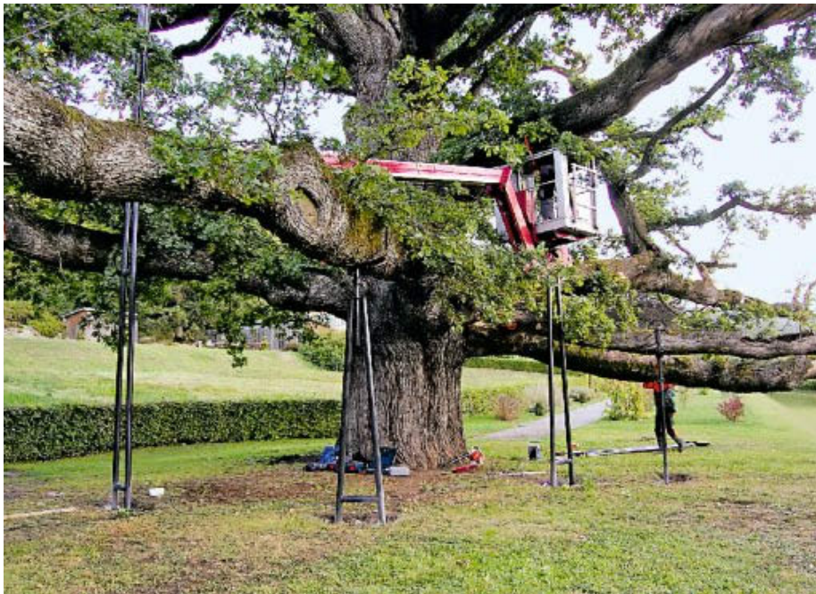
Einbau der A-Stützen im Herbst 2012 durch die Firma Jakob-Baumpflege, Fladungen
